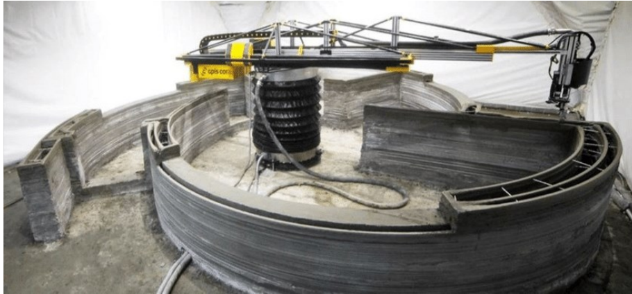
Figura 6.5. Fabricación aditiva por extrusión de hormigón fresco in situ [24].
