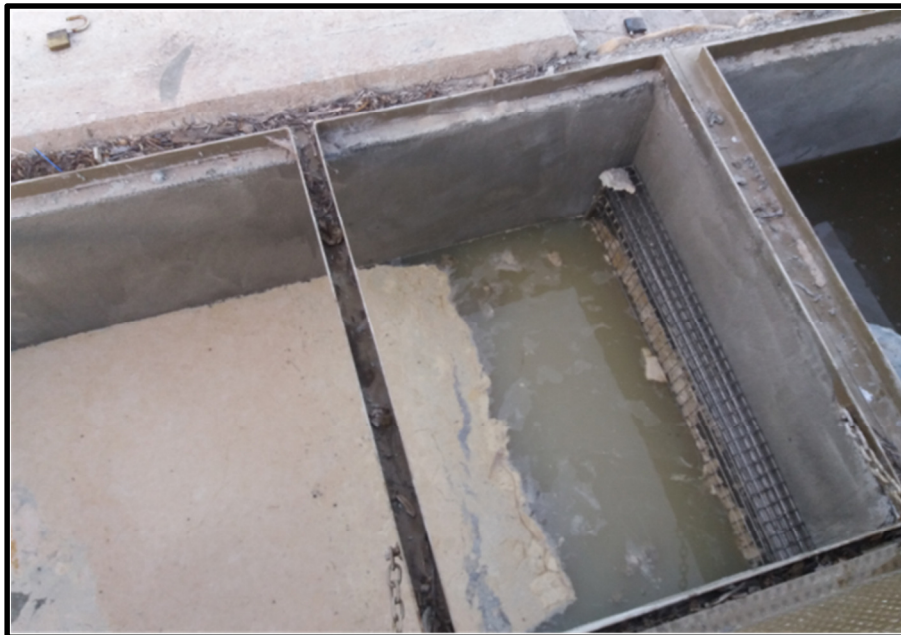
Foto 3. Imagen de posible arqueta de llegada.
