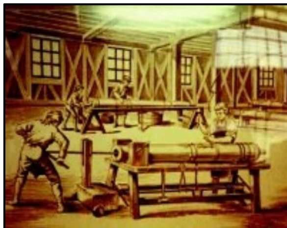
Ilustración 1: Barrenado de cañones a mano. Fuente: [7]
