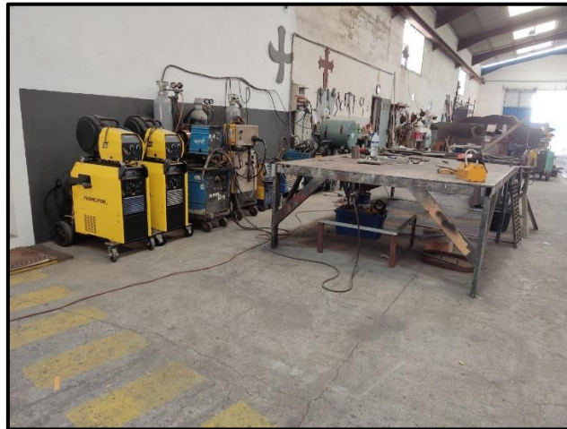
Ilustración 37: Zona para soldadura. Fuente: Trabajo de campo.
