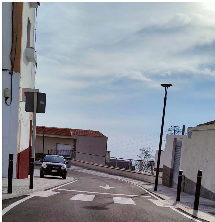
Fotografía 4. Calle Carretera General
