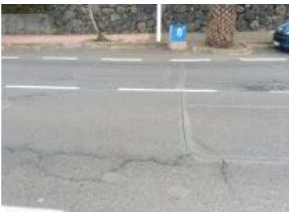
Foto 37 Estación de aforo
