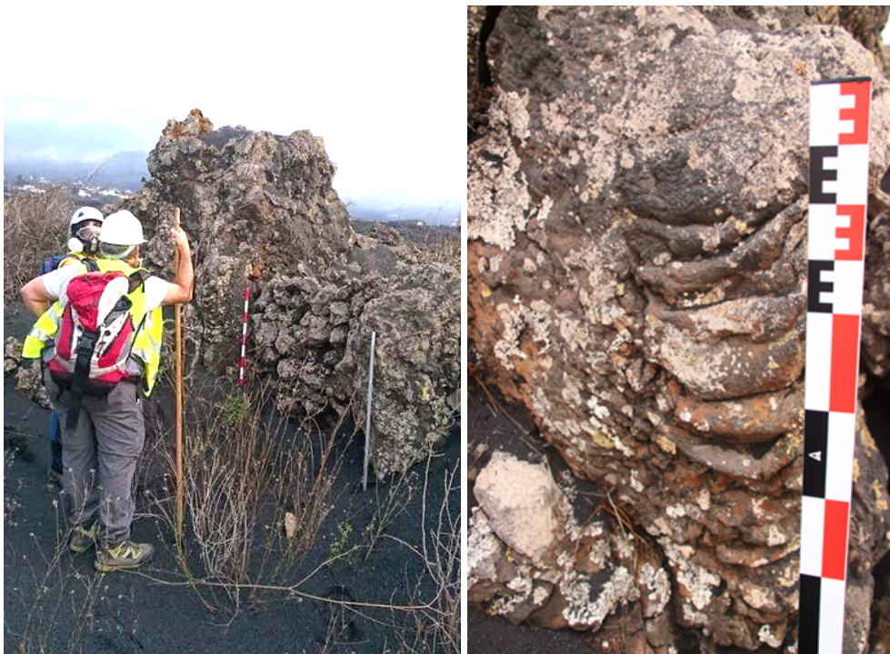
Figura 23. Muro de piedra seca cerrando un espacio entre bloques basálticos, y detalle de las lavas cordadas en un bloque en posición vertical.
