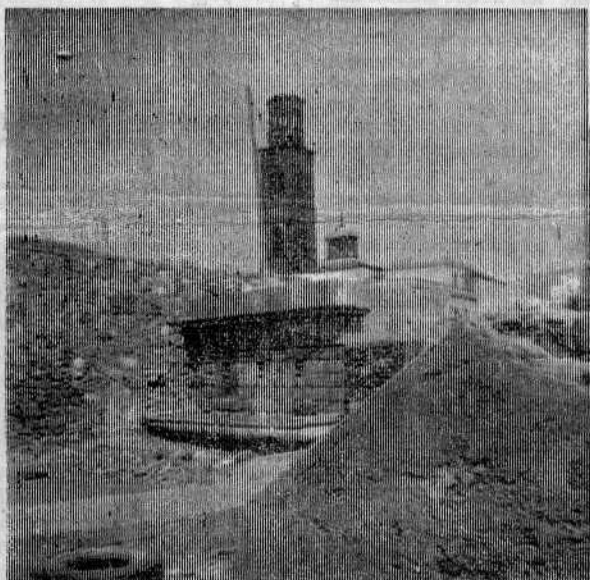
La torre de la Concepción da sombra a la centenaria Fuente de Morales que, parcialmente, asoma su estampa de granito —perdurable— como en súplica de su rescate.—(Foto Alfonso Esteban)
