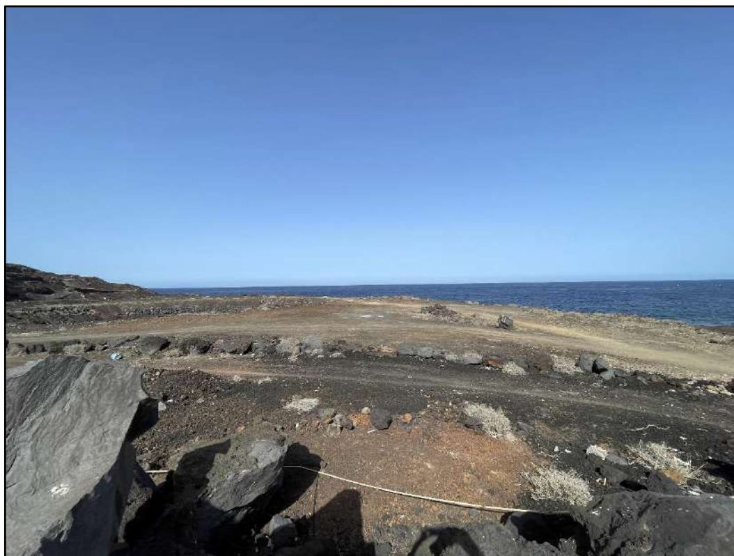
Figura 6. Explanada de la zona de Proyecto
