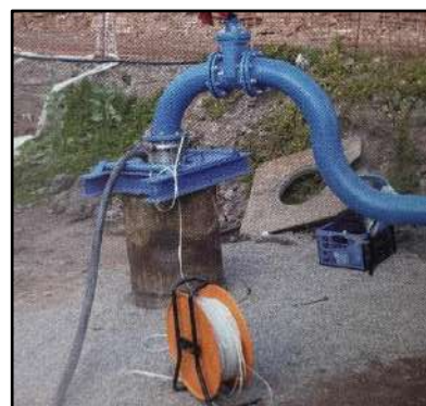
Figura 8. Instalación provisional de un sondeo para ensayo de bombeo.
