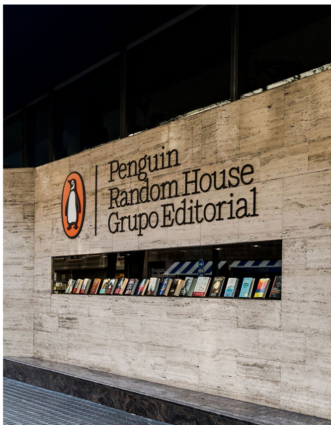
Sede en Barcelona del grupo editorial Penguin Random House [Fotografía]. Recuperado de https://www.penguinrandomhousegrupoeditorial.com/oficinas-y-contactos/oficina/espana/
