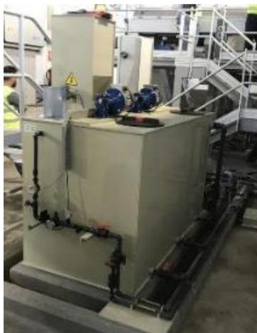
*Figura 33 Sistema de preparación de polielectrolito de EDAR de Valle de Guerra*
