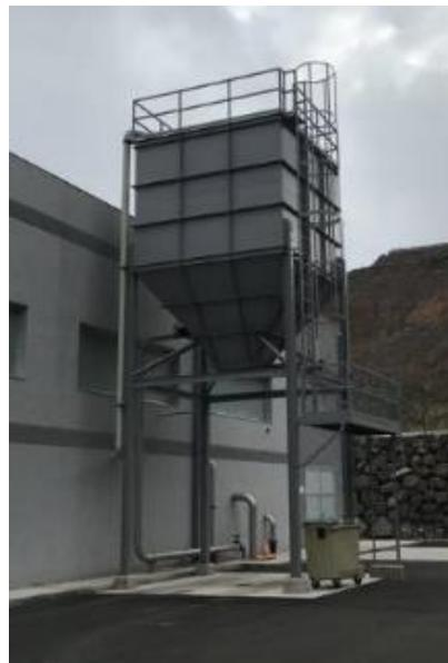
*Figura 35 Silo de almacenamiento de lodos de EDAR del noreste de Tenerife*
