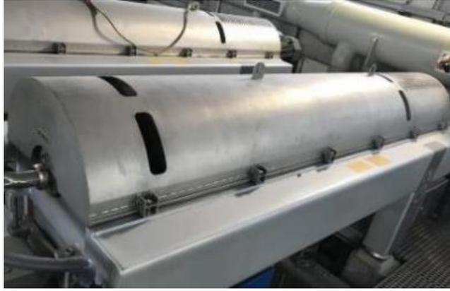
*Figura 34 Sistema de deshidratación centrifuga de EDAR del noreste de Tenerife*
