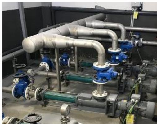
*Figura 32 Sistema de bombeo de lodos espesado de EDAR de Valle de Guerra*
