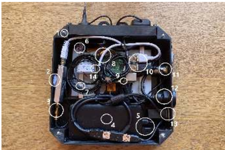
Figura 4.5: Interior de la estación AIS portátil.
