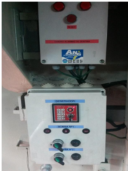
Ilustración 13: Cuadro de funcionamiento de bombas y generador
