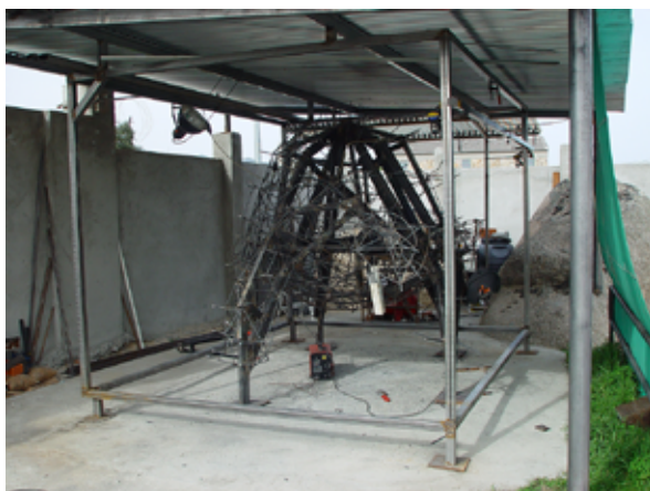
Fig. 14. Ana E. Balboa González, Imagen de la triangulación realizada con las varillas de acero sobre todo el volumen de la figura , enero 2004, fotografía digital de 10 667 × 8000, archivo de Ana E. Balboa González, Madrid, España. Fuente: archivo personal.
