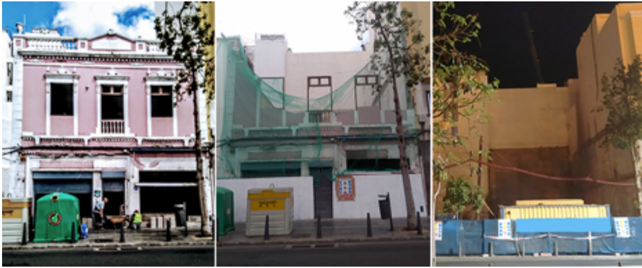
Fig. 3. Típico proceso de demolición que está afectando a muchos palacetes y casas terreras de La Isleta. Elaboración propia.
