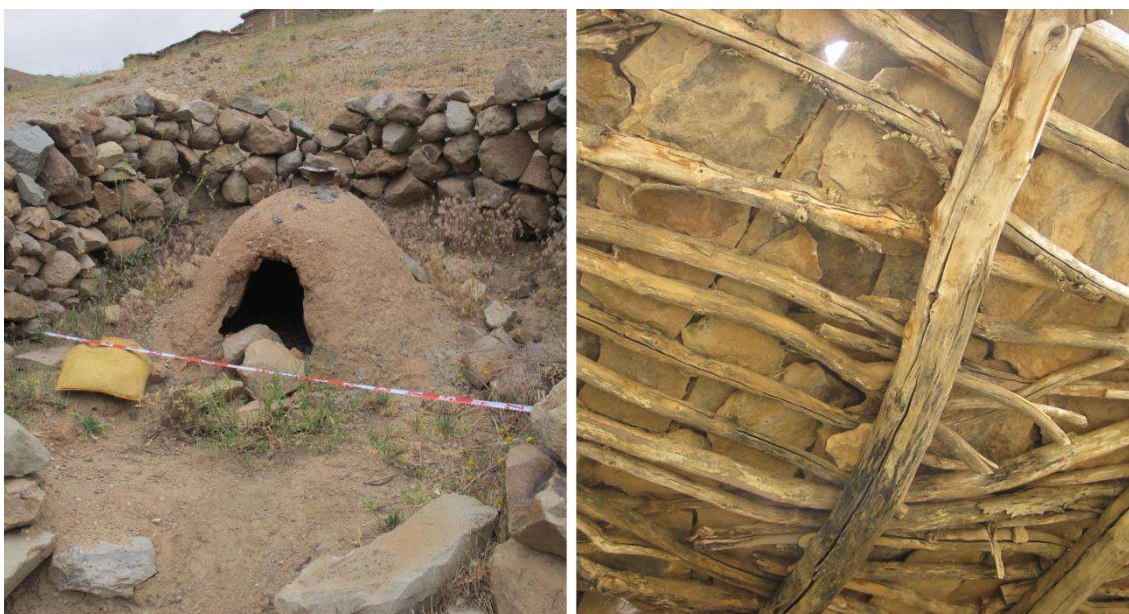
Figura 68. Caso de horno colectivo (izquierda) y de techo con estructura de madera (derecha: fotografías del autor) en el azib de Tiquirit.
