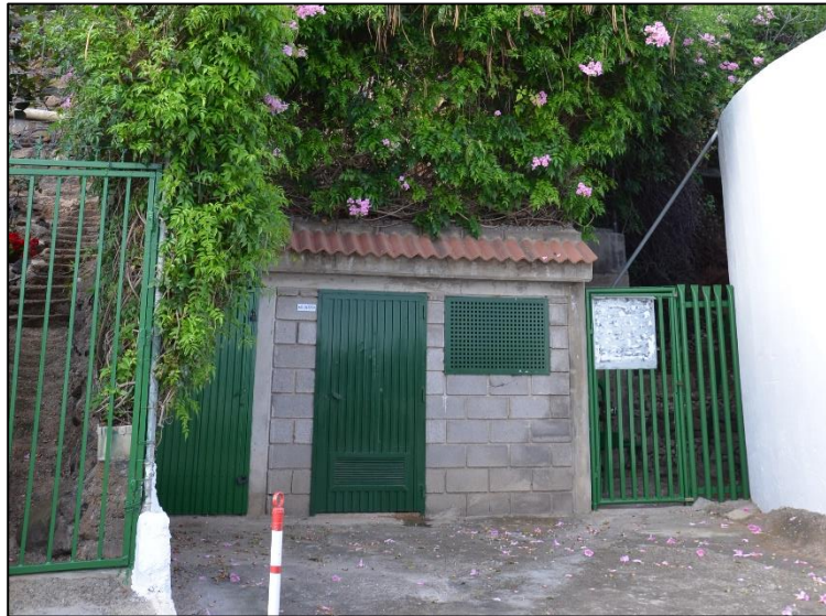
Figura 10. Imagen de una de las casetas ubicada en la zona alta de la red
