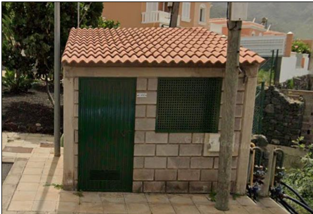
Figura 18. Caseta Tipo III
