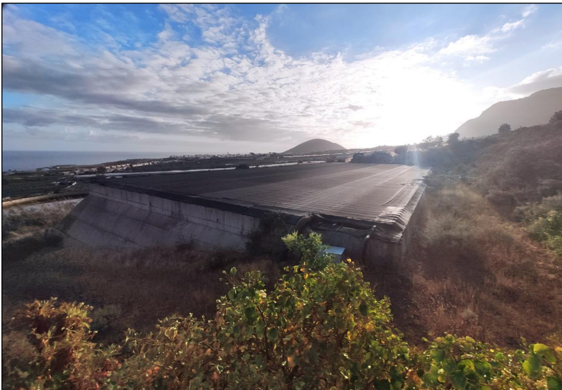
Figura 10. Depósito El Rincón
