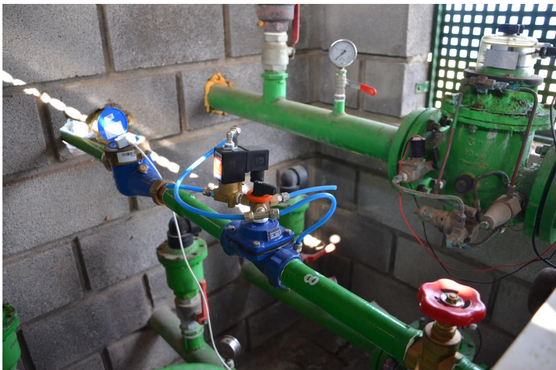
De izquierda a derecha. Contador – Piloto regulador de presión – Válvula de cierre manual
