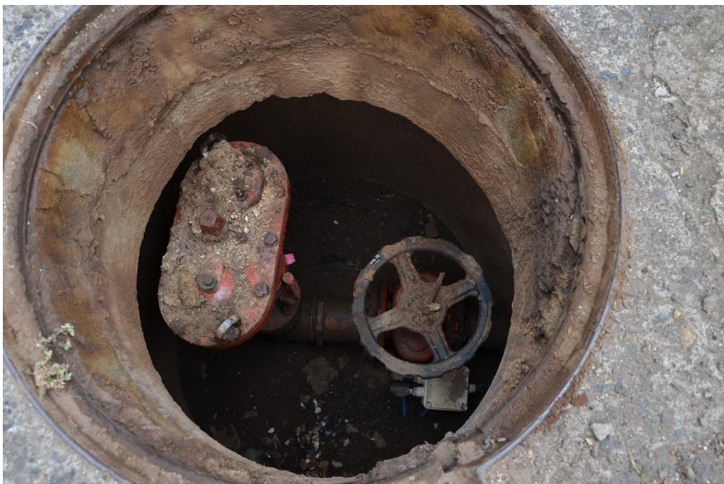
Figura 13. Interior de una arqueta compuesta por una ventosa y una válvula de corte
