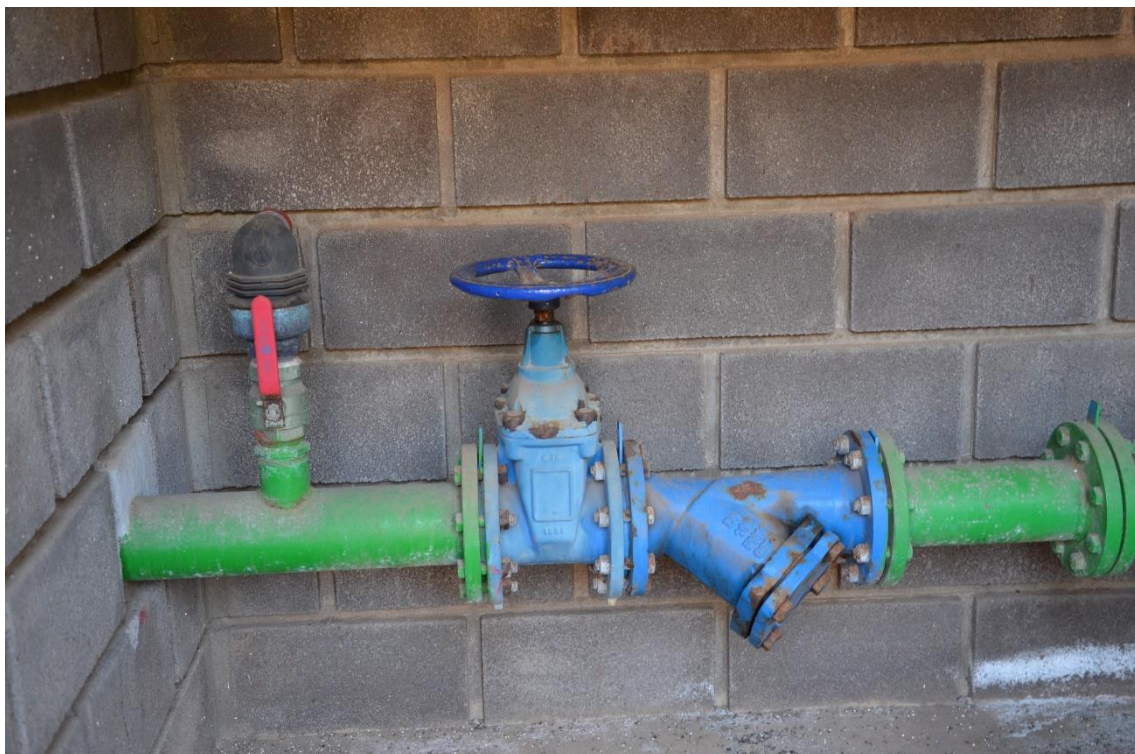
Figura 7. Interior de una caseta de la red
