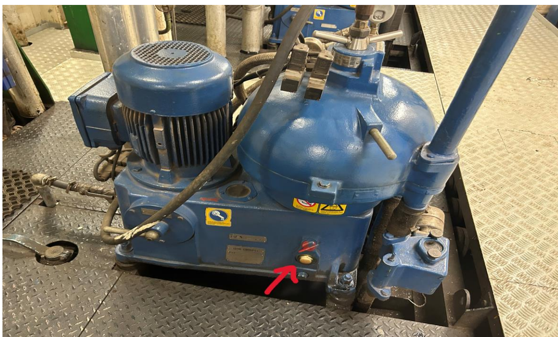
Ilustración 50. Toma para cambio de aceite lubricante.
