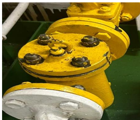
Ilustración 24. Filtro de la bomba de alimentación de aceite.
