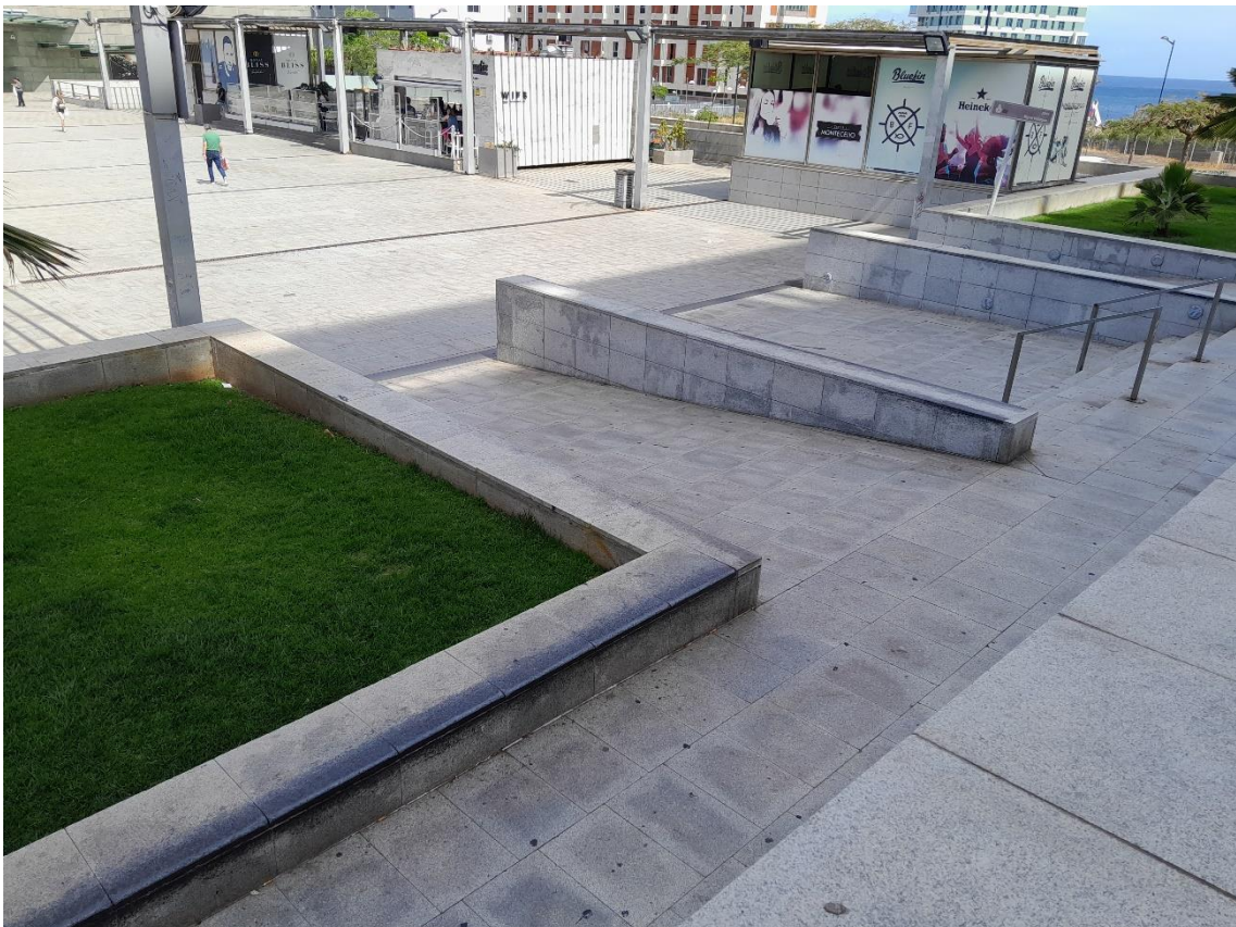
FIGURA 10: SPOT SITUADO EN LA PLAZA DEL CORTE INGLÉS DE SANTA CRUZ DE TENERIFE. OBSERVANDO LOS BORDILLOS PUEDEN APRECIARSE LAS TÍPICAS MARCAS (LA PARTE OSCURA) QUE SE PRODUCEN CON EL USO CONTINUADO DEL SKATE, GENERALMENTE AL GRINDAR (FOTOGRAFÍA TOMADA EL 5 DE MAYO).
