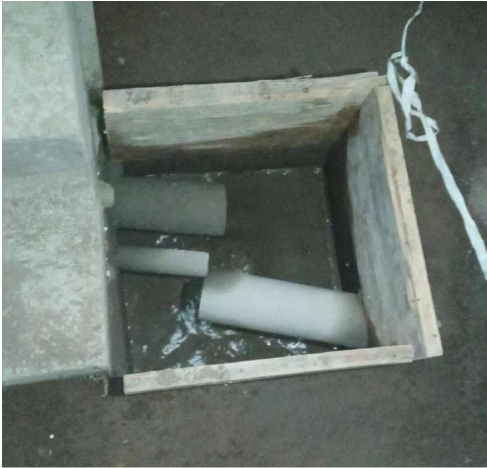
Arqueta en sótano
