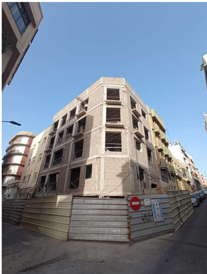
Estado actual de la fachada
