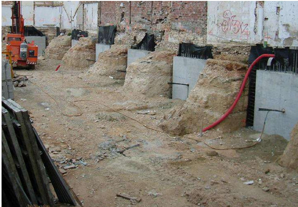
Ejemplo de excavación por bataches
