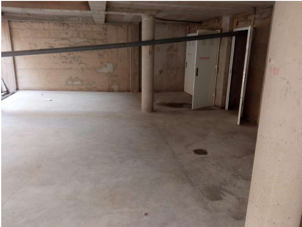
Rampa de garaje y sumideros
