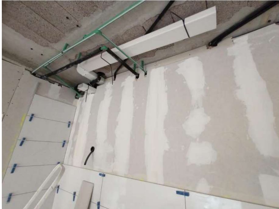
Estado actual del interior de la obra
