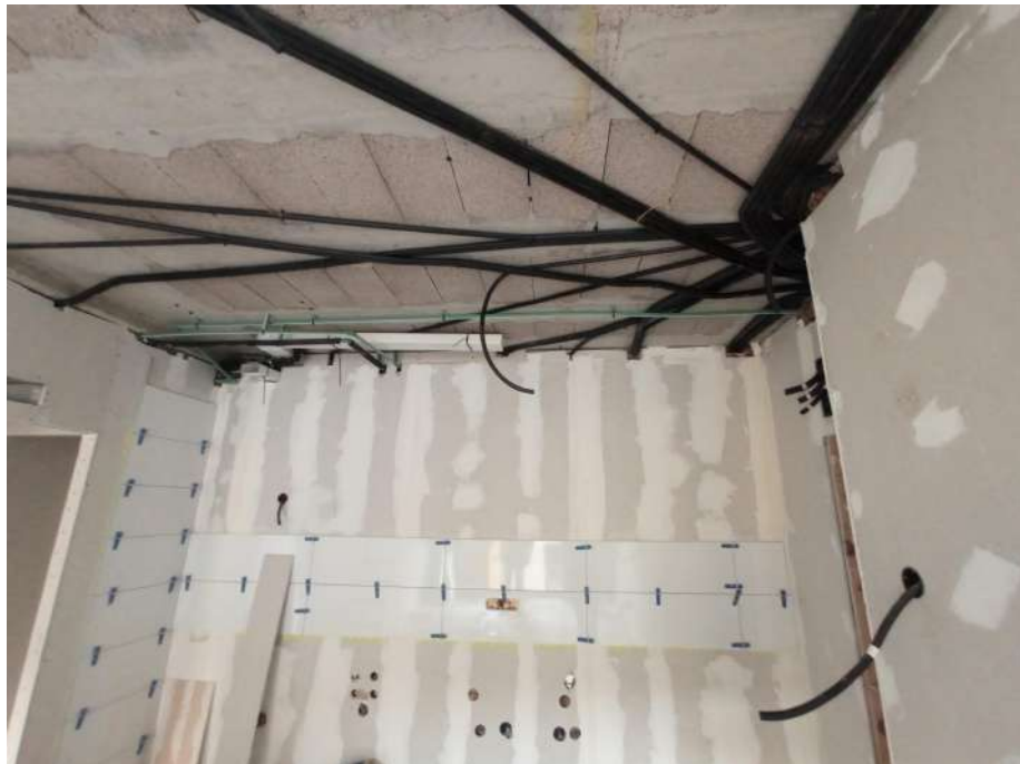
Estado actual del interior de la obra
