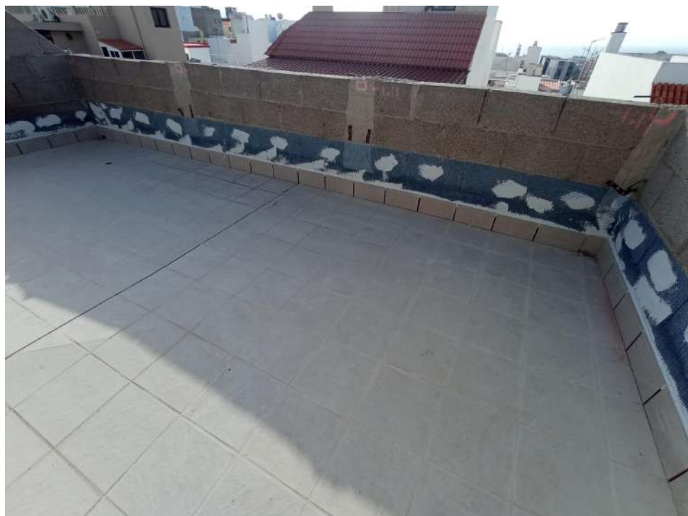
Estado actual de la cubierta
