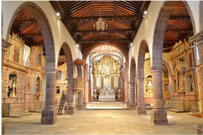
Fig. 1. Vista general de la iglesia
