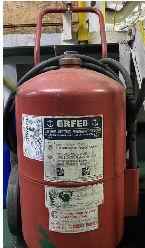
Ilustración 41. Extintor portátil de espuma de 45 litros. Fuente: Elaboración propia
