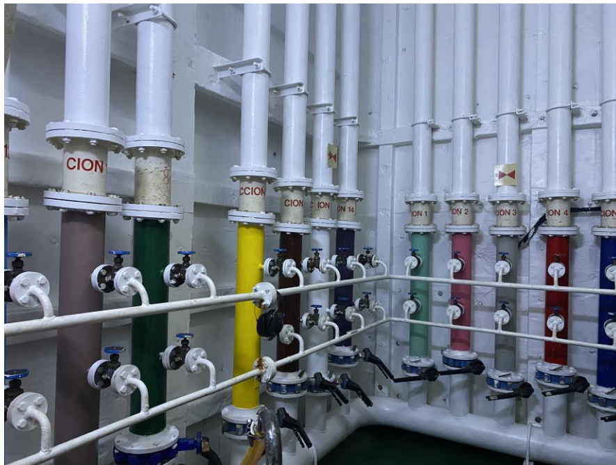
Ilustración18. Secciones de rociadores. Fuente: Elaboración propia
