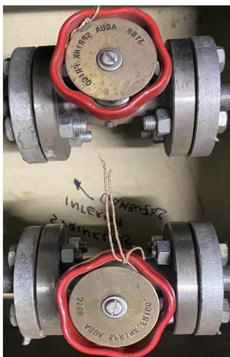
Ilustración13. Disparo línea seca de la gambuza. Fuente: Elaboración propia
