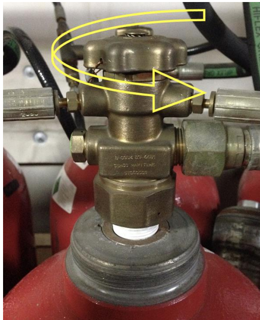
Ilustración31. Apertura manual de la botella de dióxido de carbono. Fuente: Elaboración propia
