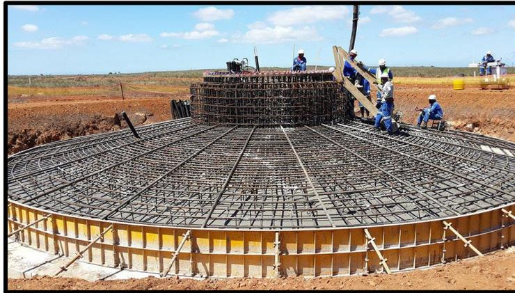
Figura 4.3. Construcción de la cimentación para un aerogenerador [24]
