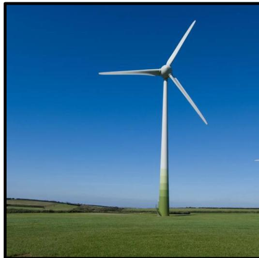
Figura 4.1. Aerogenerador de eje horizontal tripala [23]
