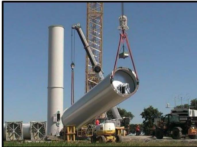
Figura 4.6. Montaje de torre tubular de acero para un aerogenerador [27]
