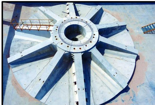
Figura 4.5. Cimentación prefabricada para torre eólica [26]
