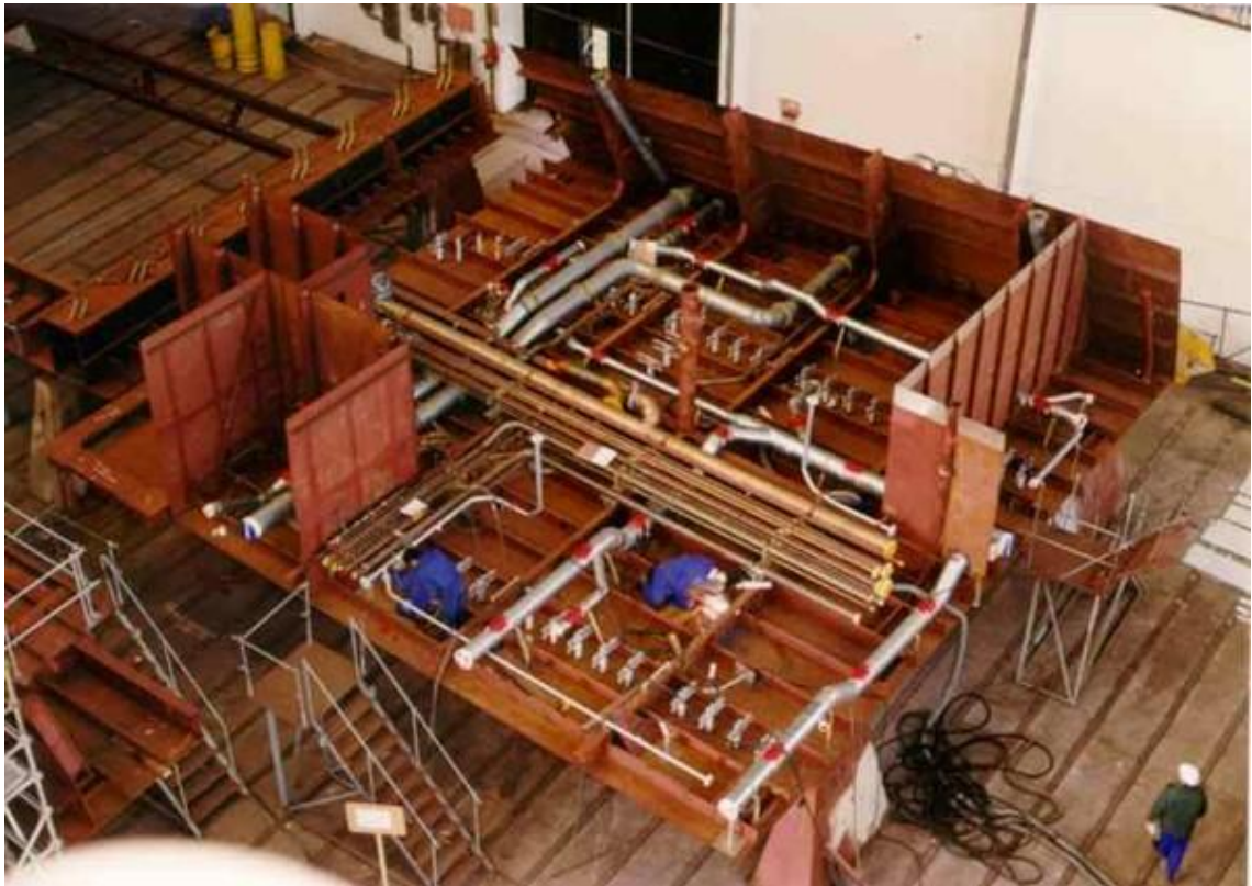
Ilustración 9. Modulo de tuberías en la fabricación de un buque en Ferrol. Fuente: https://exponav.org/blog/construccion-naval/estrategia-constructiva-aplicacion-en-buques/
