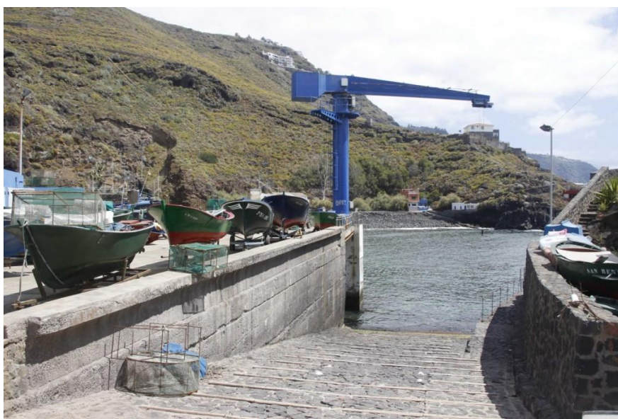
Ilustración 19. Rampa de varada ubicada en El Pris (Tenerife). Fuente: https://diariodeavisos.elespanol.com/2016/08/costas-aprueba-dique-pris-demandado-los-pescadores-desde-50-anos/
