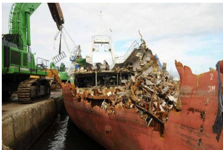
Ilustración 13. Desguace de un buque en el muelle de Vigo. Fuente: https://noticiaslogisticaytransporte.com/
