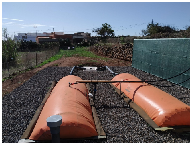
Imagen 2. Biodigestor de PVC reforzado muy similar al utilizado en el proyecto. Fuente: AIDER Gran Canaria
