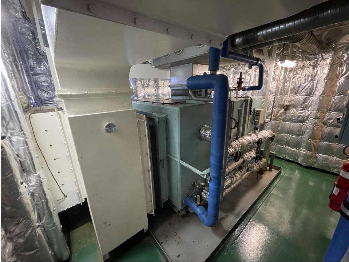
Figura A.2: Entrada de aire al climatizador Fuente:Elaboración propia
