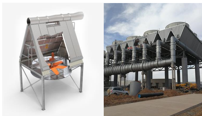
Figura 90 Condensadores enfriados por aire para geotermia. Fuente: SPG DryCooling.
