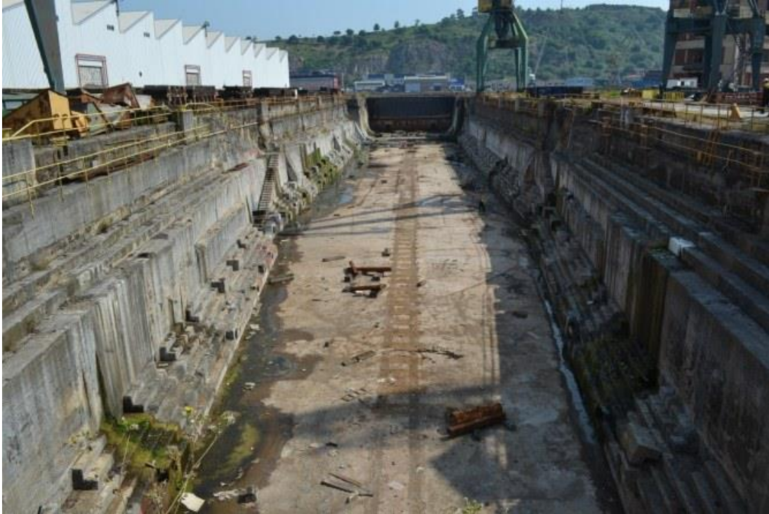
Ilustración 6: Paredes laterales de hormigón. Fuente:
