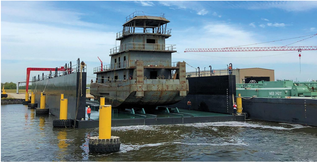
Ilustración 26: Remolcador en construcción en el dique flotante. Fuente:
