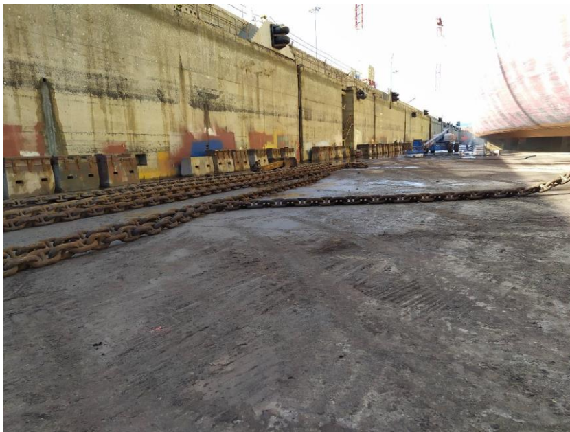
Ilustración 5: Piso de hormigón en dique seco, Algeciras. Fuente: Elaboración propia.
