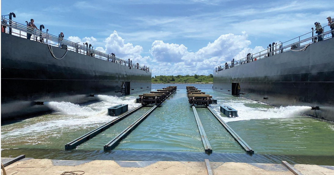
Ilustración 25: Deslastrando un dique flotante. Fuente:
