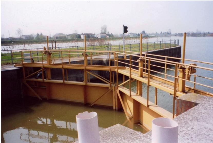
Ilustración 11: Puerta de inglete. Fuente: https://www.vortexhydradams.com/hydraulic-works/miter-gates/
