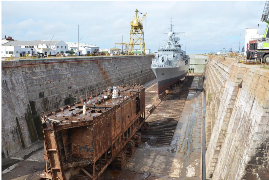
Ilustración 9: Construcción de puerta flotante. Fuente:
