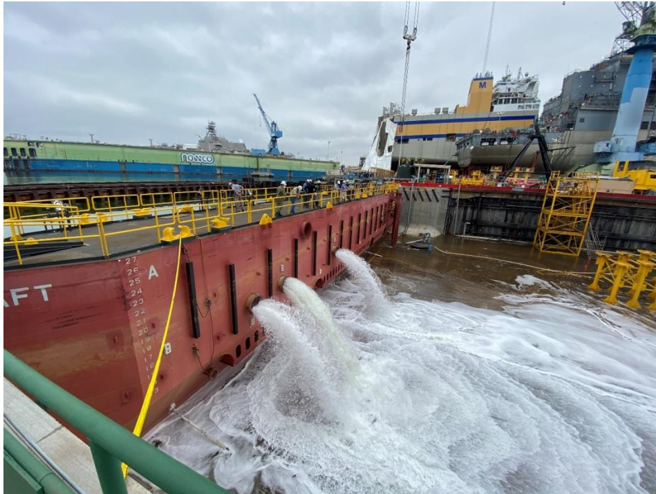
Ilustración 7: Operación de inundación a través de la puerta del dique. Fuente:
