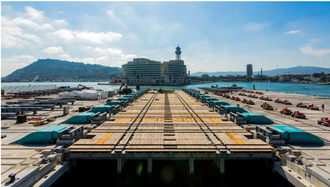
Ilustración 31: Nuevo elevador de barcos en el puerto de Barcelona. Fuente: https://elmercantil.com/2019/08/30/el-puerto-de-barcelona-estrena-un-nuevo-elevador-de-barcos-de-4-800-toneladas/
