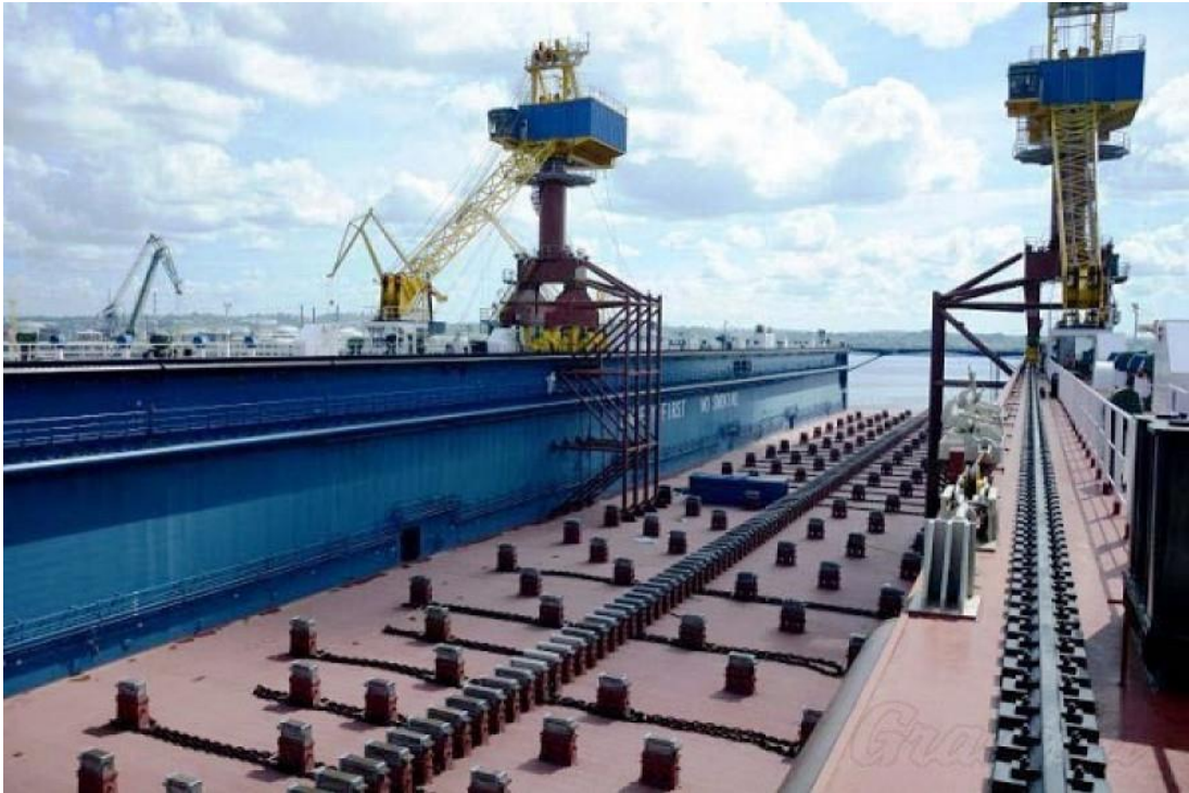
Ilustración 17: Dique flotante con capacidad para buques Panamax. Fuente:
