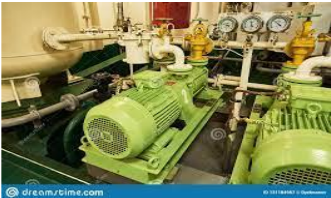
Ilustración 2. Motores Dhalander para bombas en la sala de máquinas de un buque. Fuente: Imágenes de Internet.
