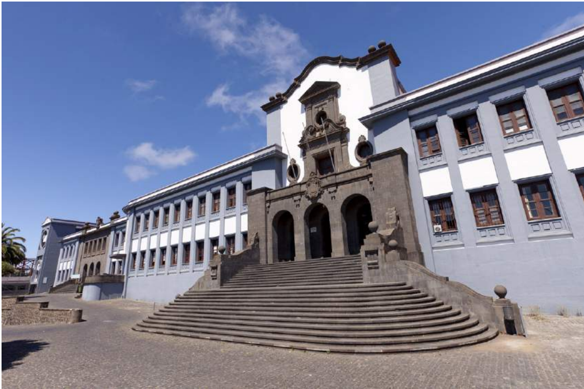
Exterior del edificio central.
