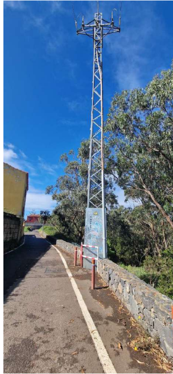
Imagen 7. Apoyo eléctrico Alta tensión. C/ Padilla Alta. Fuente: Anejo nº 4 “Fotogrametría”.
