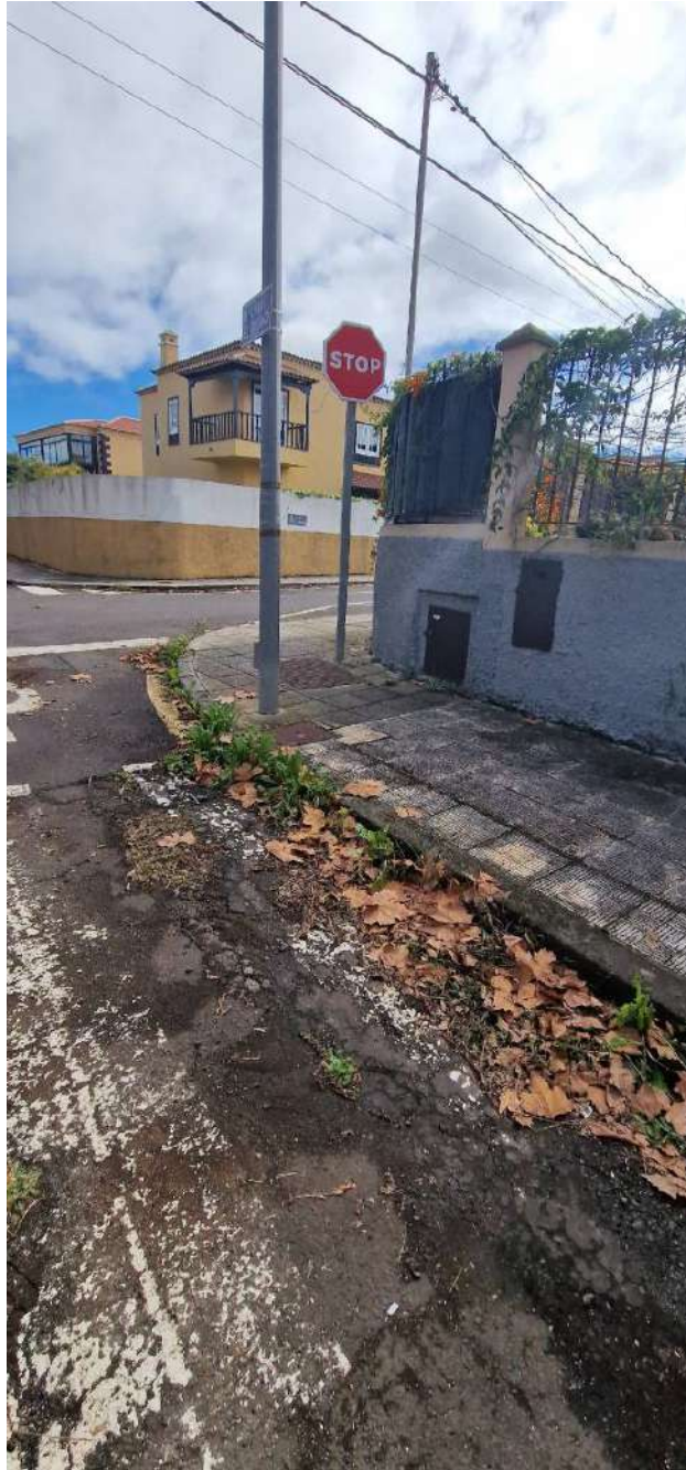
Imagen 10. Arquetas eléctricas situadas en las aceras de la calle el Fresno.
