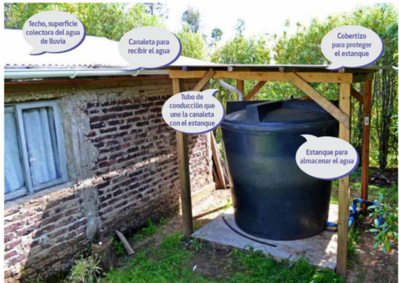
Captación de lluvia desde un techo y almacenamiento en un estanque. Fuente: Programa de las Naciones Unidas para el Desarrollo.
