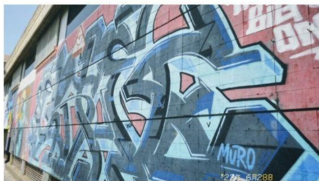
Fachada de edificio abandonado en Santa Cruz de Tenerife |Y.C:
