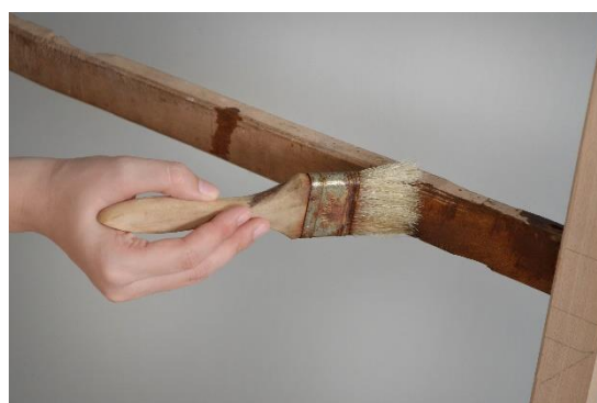
Figura 135.- Aplicación de Xylamon con brocha sobre toda la superficie.
