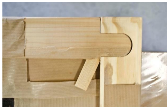
Figura 110.- Inserción de cuñas para tensar.
