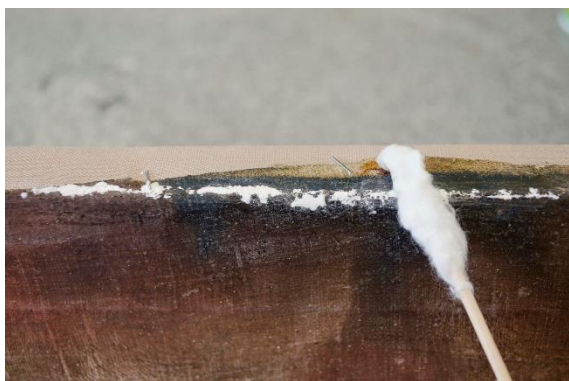
Figura 152.- Enrasado de las zonas estucadas con humedad.
