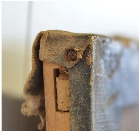
Figura 67.- Vista del ensamble del bastidor.
