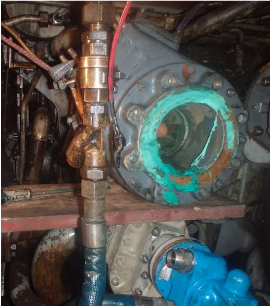
Ilustración 56: Bomba de agua a punto de ser retirada
