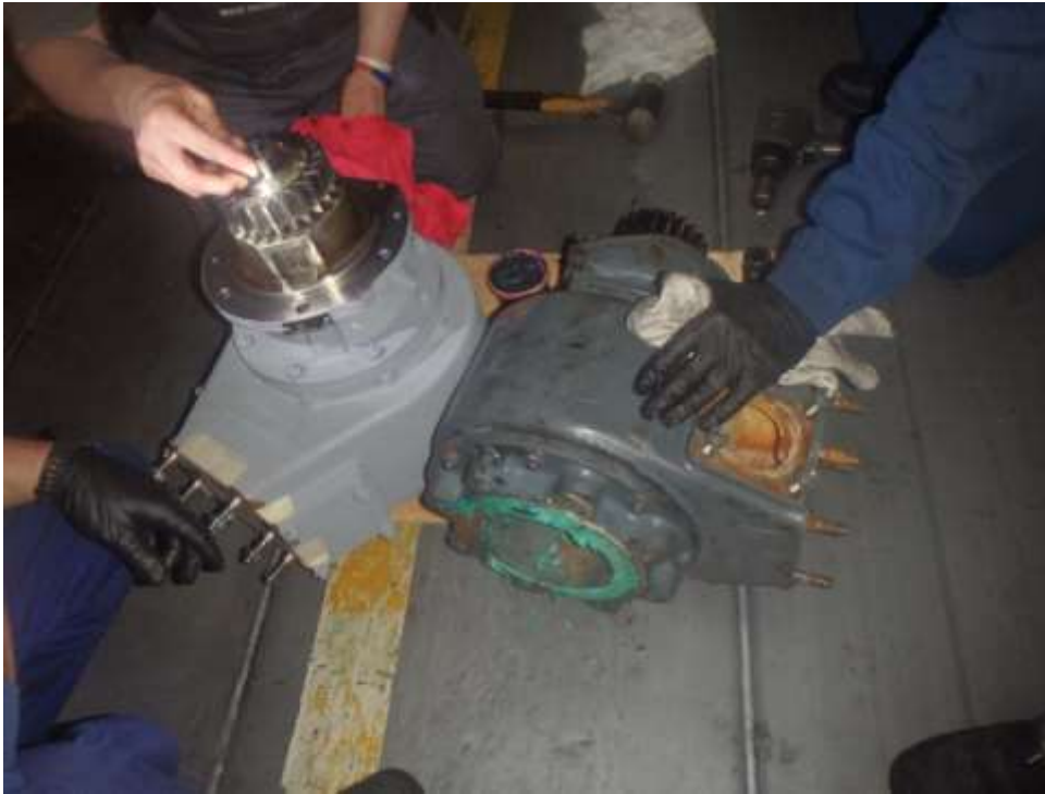
Ilustración 57: Colocación tuerca en bomba de agua salada nueva
