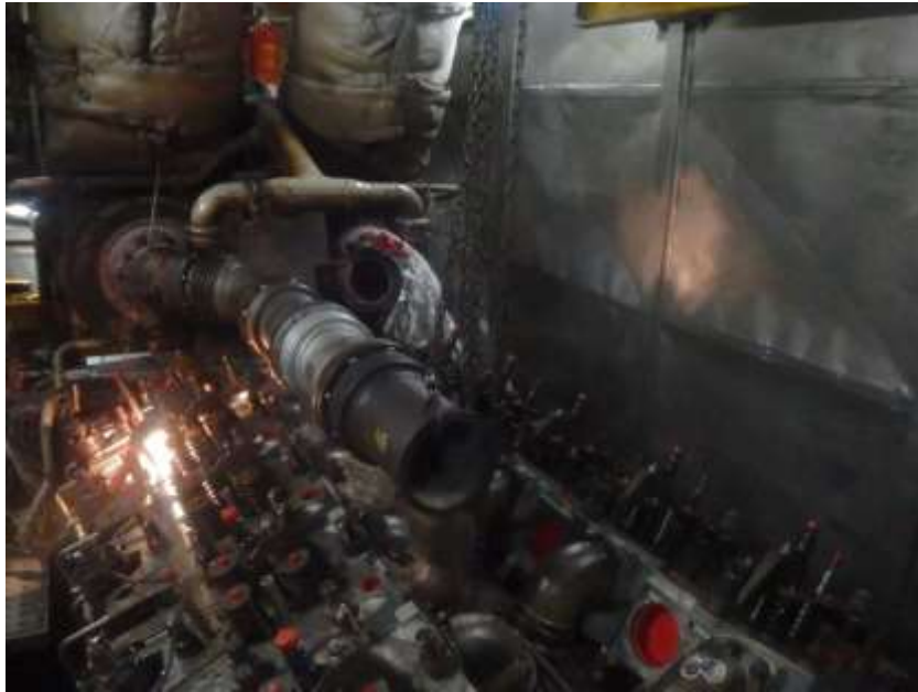
Ilustración 95: Colocación del colector de escape
