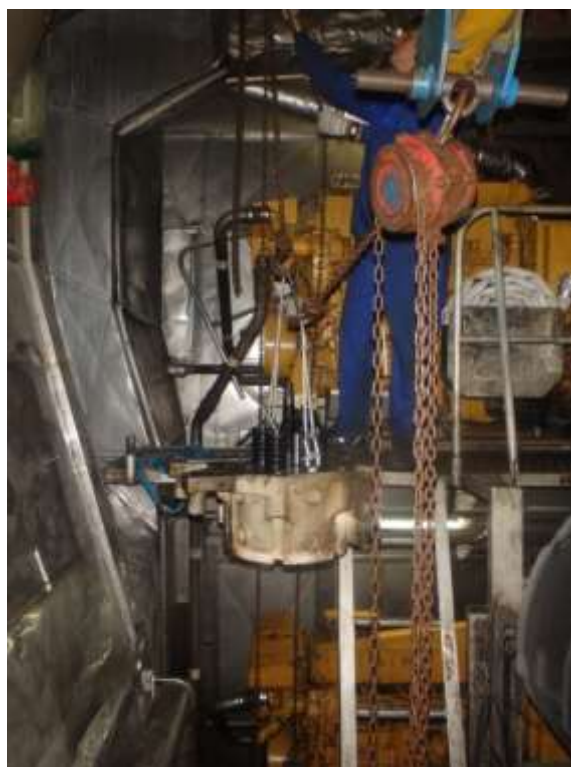
Ilustración 70: Operario izando una culata
