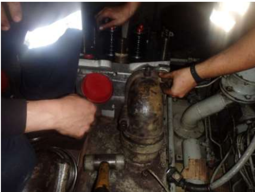
Ilustración 94: Operarios colocando el codo del colector de admisión
