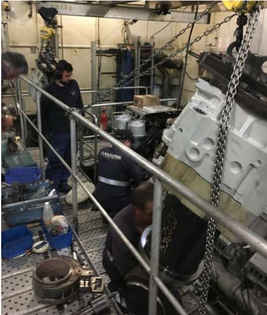
Ilustración 100: Unidad nueva al frente, Unidad defectuosa al fondo
