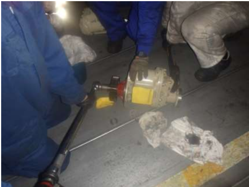
Ilustración 61: Apriete de tuerca bomba de aceite
