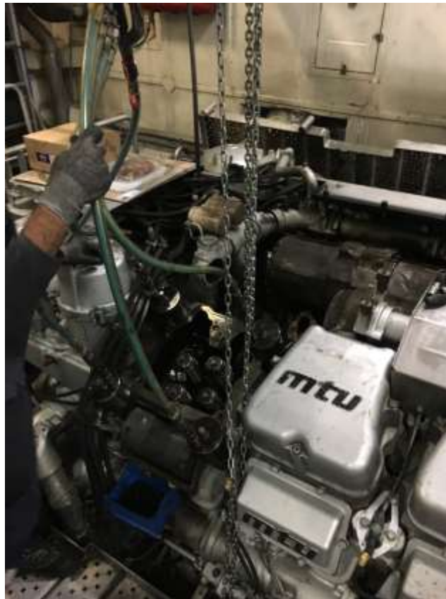
Ilustración 99: Alargamiento de los espárragos
