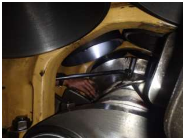
Ilustración 80: Retirada tapa cojinete de bancada
