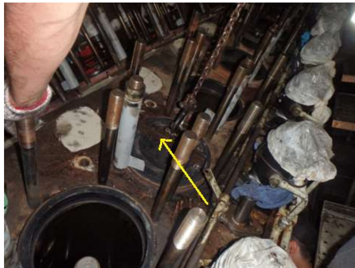
Ilustración 72 Colocación del útil de izado en la cabeza del pistón
