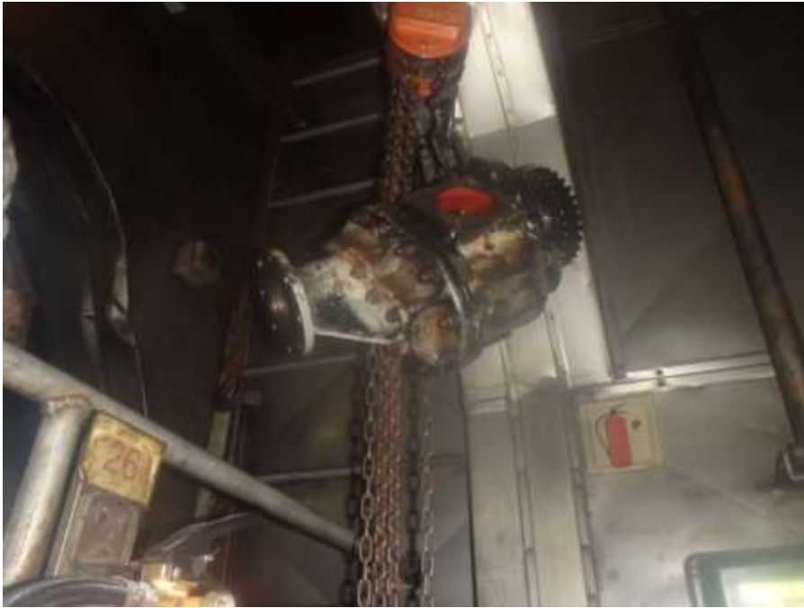
Ilustración 60: Izado bomba de aceite
