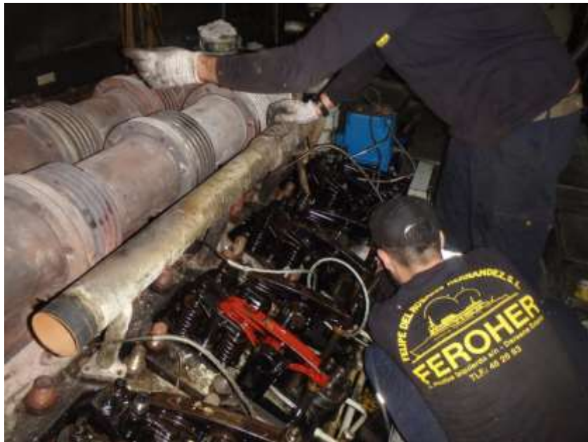
Ilustración 64: Retirada de balancines, empujadores y taqués
