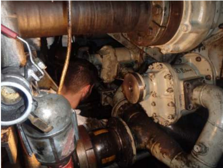
Ilustración 62: Colocación nueva bomba de aceite
