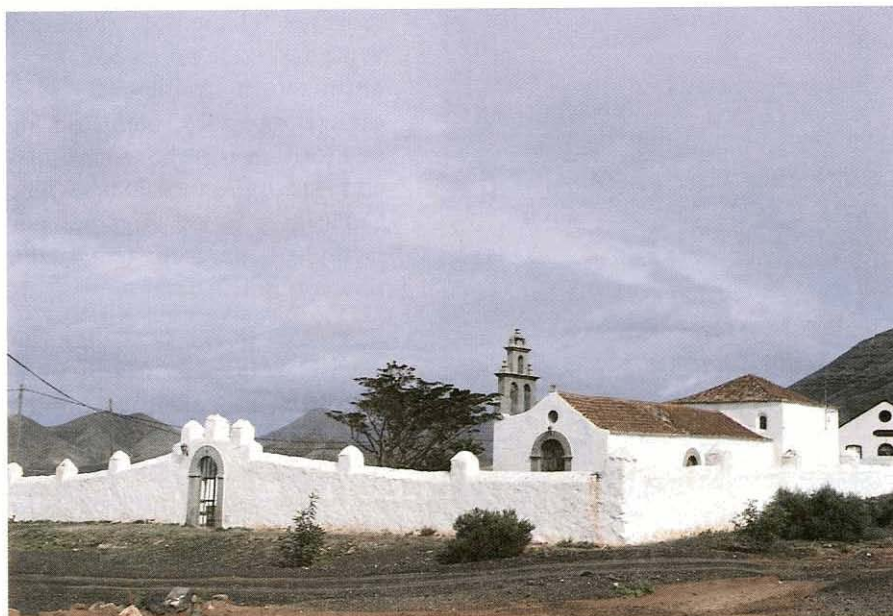
Ermita de San Pedro de Alcántara, en Ampuyenta (Fuerteventura). La barbacana constituyó un elemento de gran arraigo en la arquitectura mudéjar.
