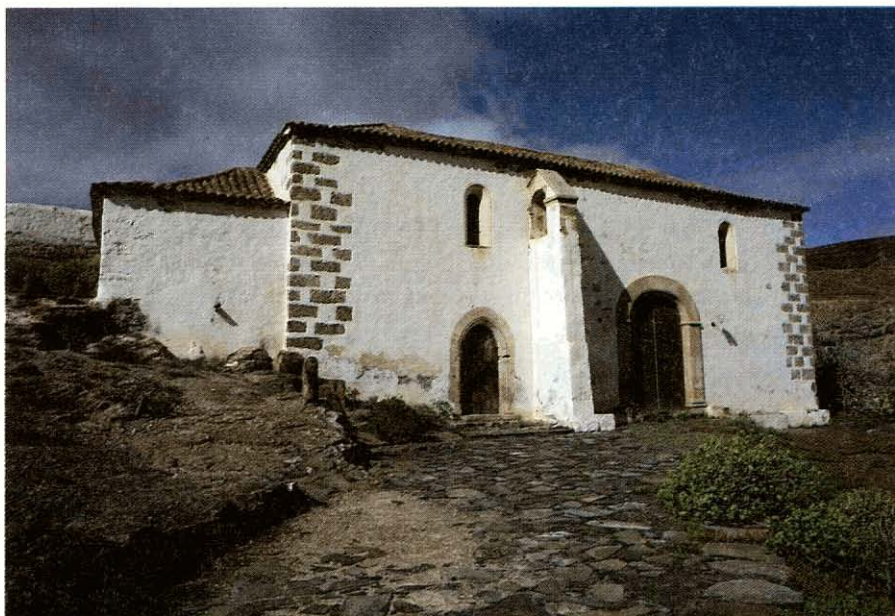
Ermita de San Diego de Alcalá, en Betancuria (Fuerteventura). La pervivencia del contrafuerte como elemento de descarga.
