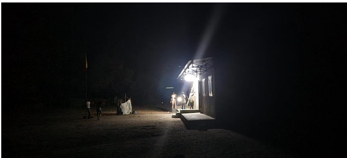
Figura 4: Comprobación del correcto funcionamiento de la instalación fotovoltaica en la escuela.
