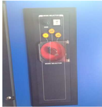
Fig. 3.67 Conmutador manual. [5]
