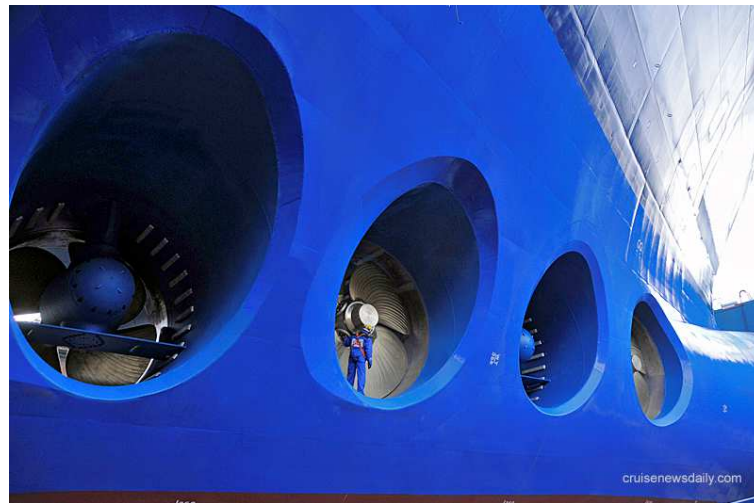
Fig. 1.16 Propulsores Túnel de proa. [11]
