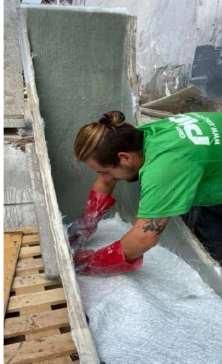
Ilustración 10. Fabricación de soporte del depósito
