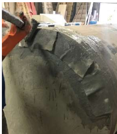
Ilustración 9. Soldadura de tapas al cuerpo del depósito
