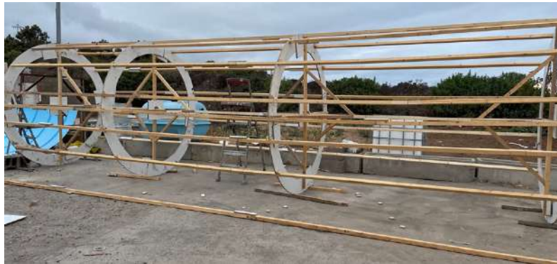
Ilustración 4. Molde de madera del depósito
