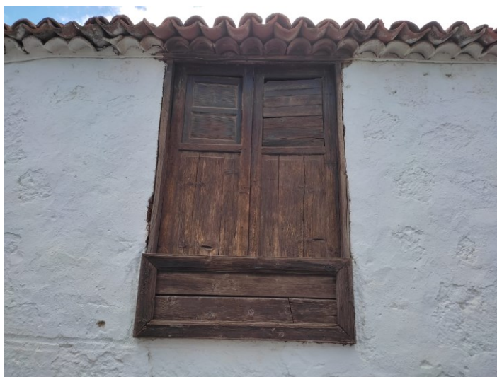
Figura 10. Ventana original hacia la vía pública. Fuente: elaboración propia.
