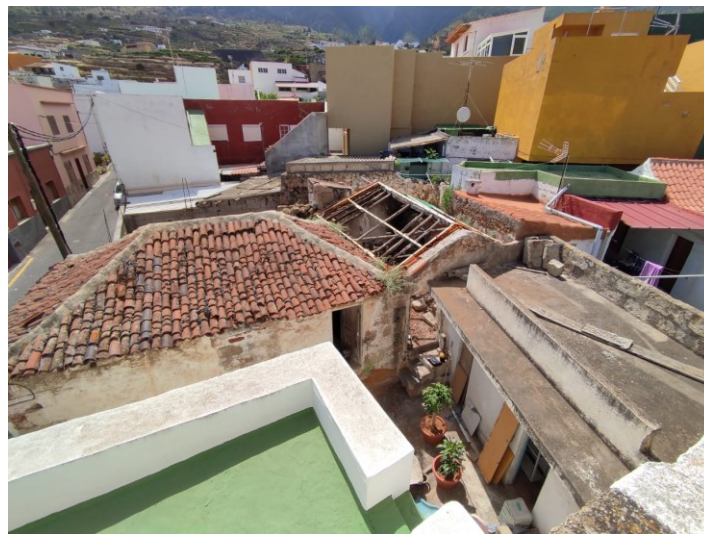
Figura 5. Vista superior del estado general de la construcción. Fuente: elaboración propia.
