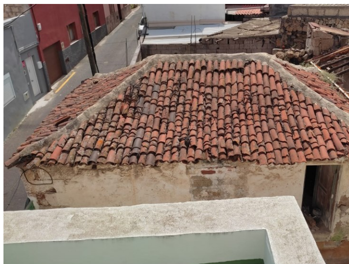
Figura 11. Cubierta de par e hilera del volumen de la 1ª ampliación. Fuente: elaboración propia.
