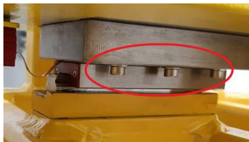
Figura 44: Anclaje de Movimiento Axial.
