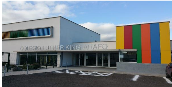
Ilustración 1. Fachada del colegio.
