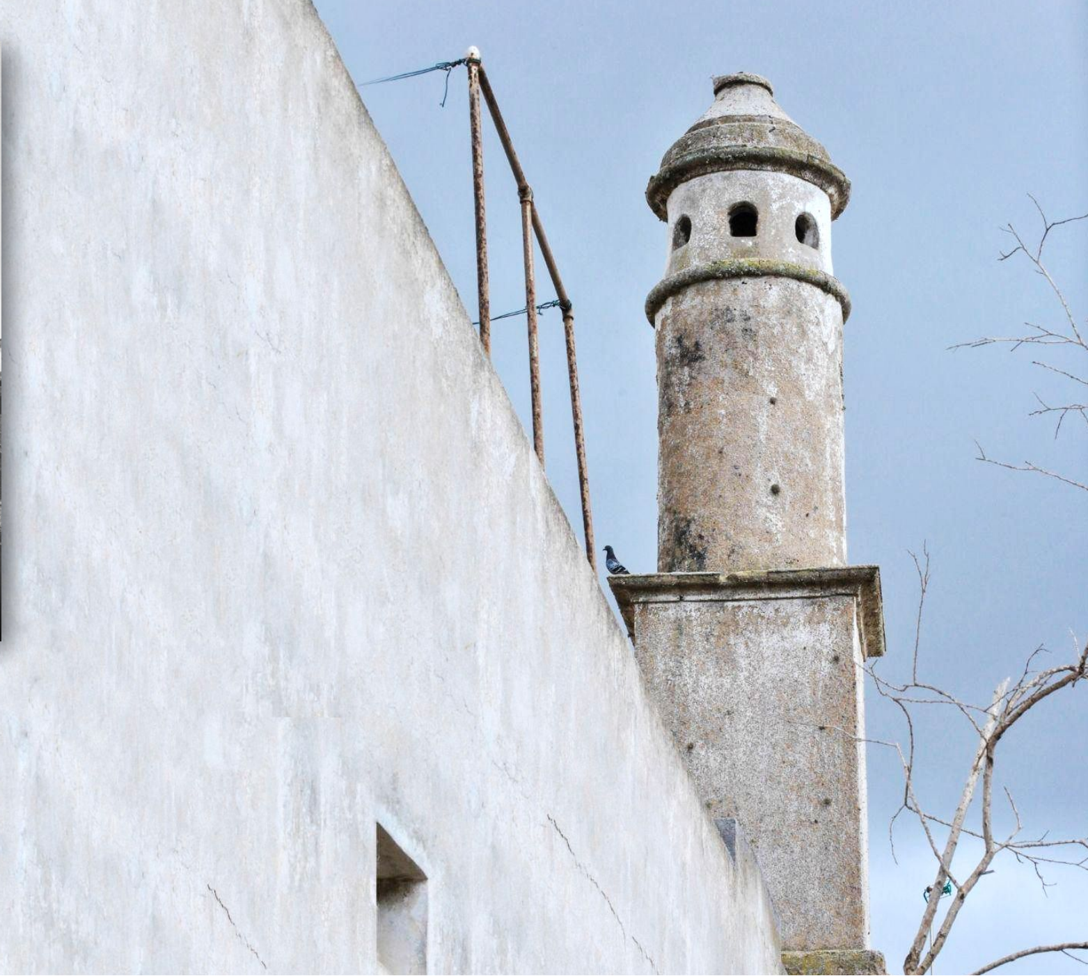
Fig. 10_ Chimenea señorial ubicada en una vivienda de la Villa de Teguiise, en el municipio de Teguiise. Fotografía de autoría propia
