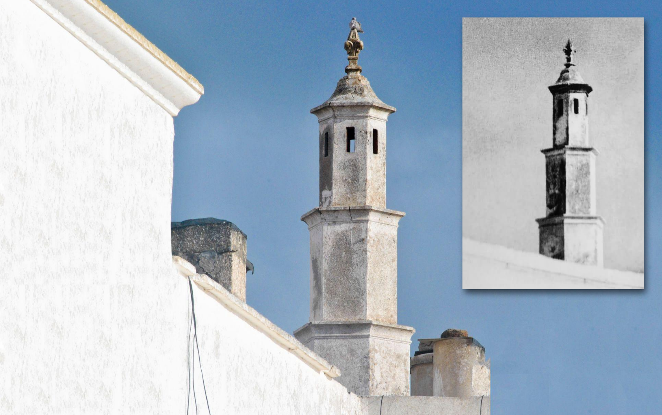
Fig. 12 _ Chimenea señorial ubicada en una vivienda de la Villa de Teguiise, en el municipio de Teguiise. Fotografía de autoría propia
