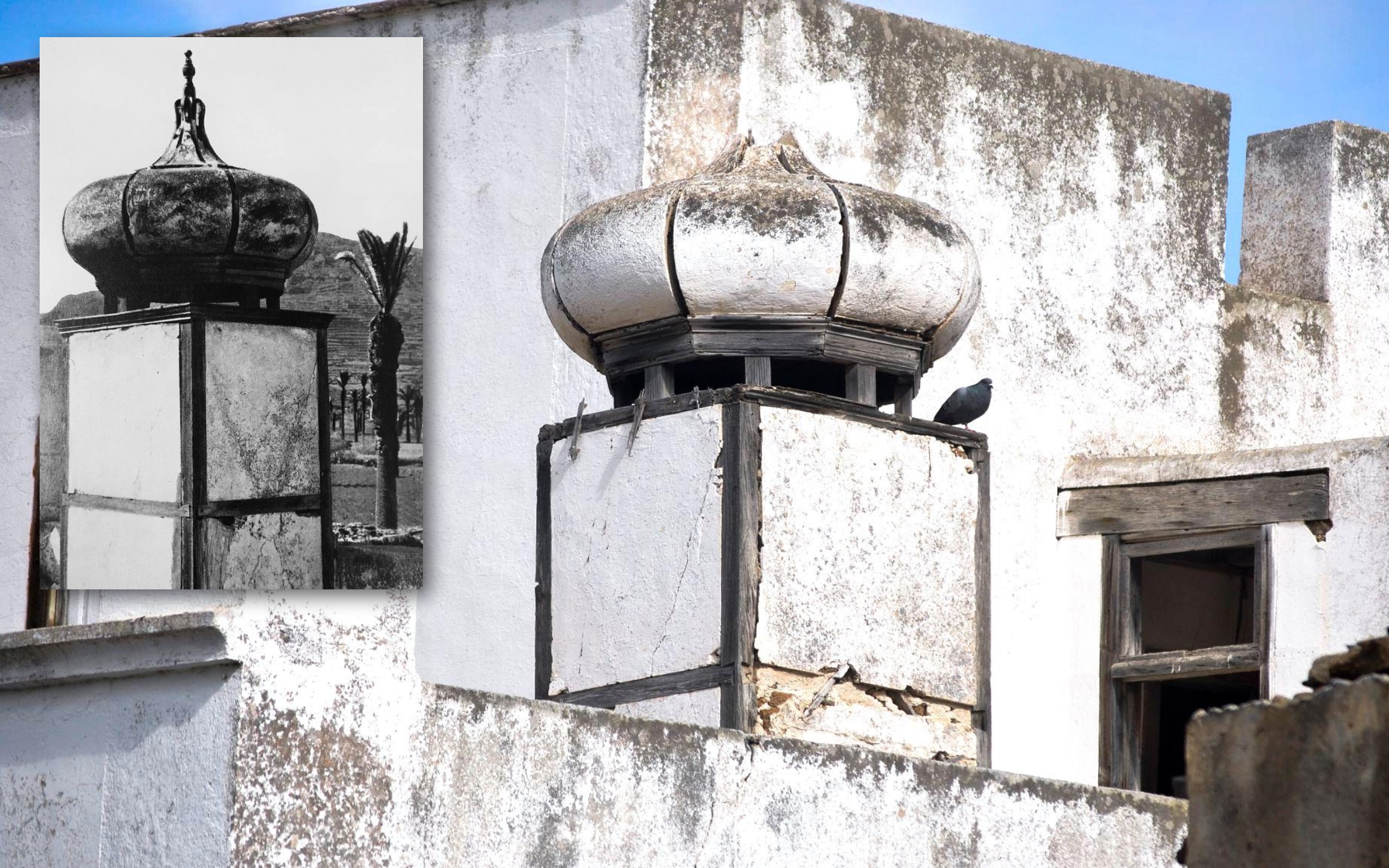
Fig. 11_ Chimenea bizantina ubicada en una vivienda del municipio de Haría. Fotografía de autoría propia
