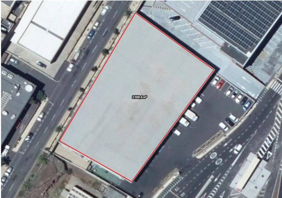
Figura 5. Área de la cubierta.
