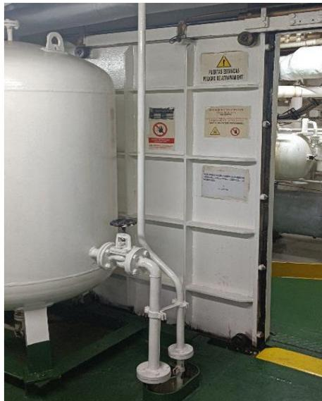
Ilustración 10. Hidróforo de agua dulce. Fuente: Elaboración propia
