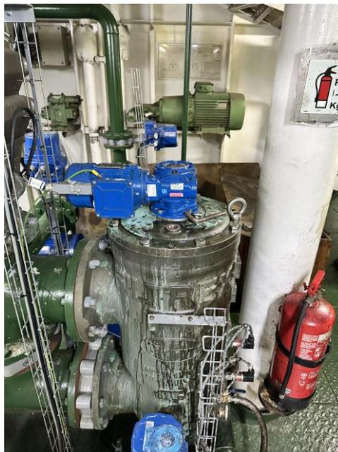
Ilustración 5. Filtro mecánico. Fuente: Elaboración propia
