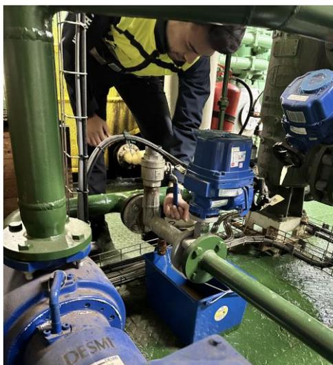
Ilustración 17. Realizando una "limpieza in situ". Fuente: Elaboración propia
