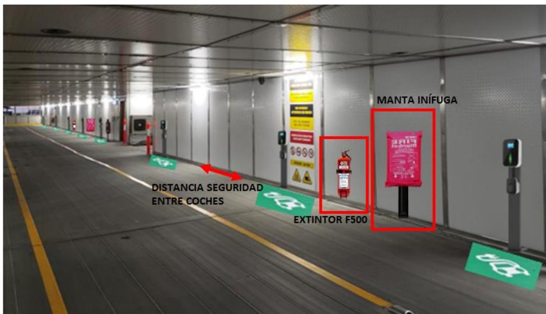
Ilustración 21. Simulación de la colocación de los extintores, mantas ignífugas y distancia entre cargadores
