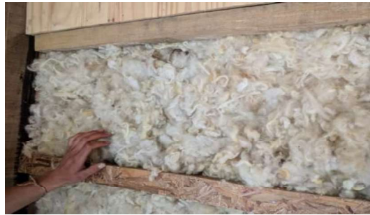
Foto: Colocación de lana de oveja en una pared en bioconstrucción. Fuente: Universidad Politécnica de Valencia
