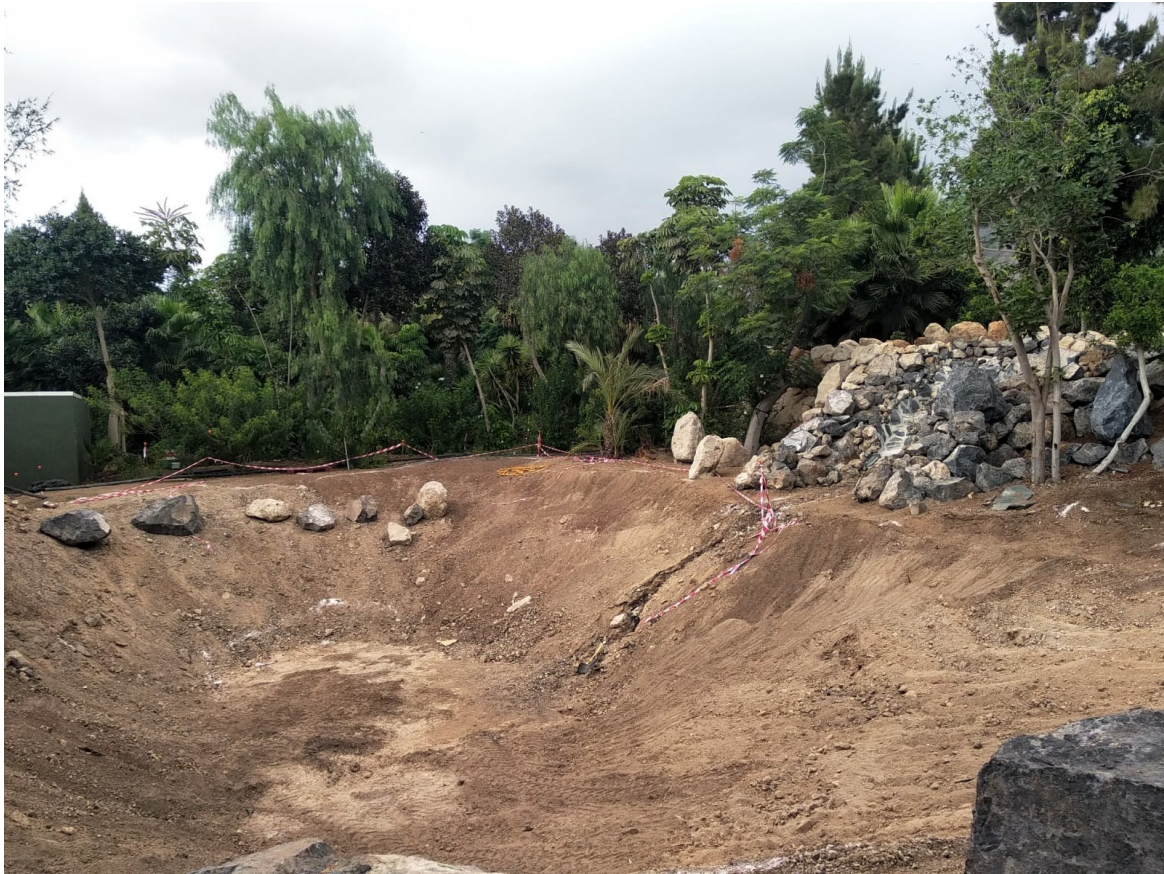
Figura 13. Laguna en construcción. Foto de autora.
