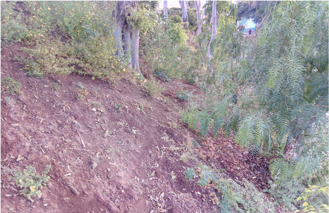
Figura 19. BUPA. Pendientes perimetrales. Foto de autora.
