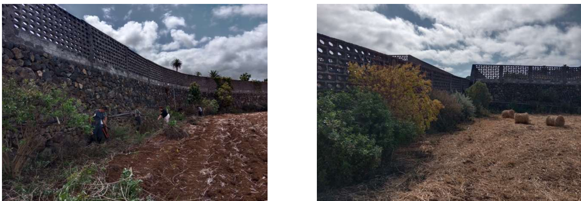
Figura 6: Aspecto actual de la parcela
