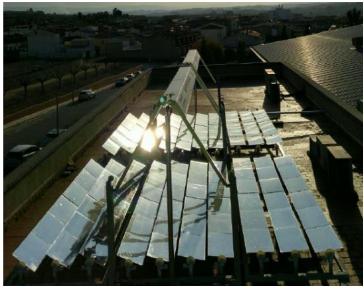
Figura 13: LFC implementado en la universidad Carlos III acorde a Famiglietti
