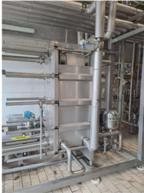
Figura 1.10. Intercambiador de placas (Mahou-San Miguel, s.f.)
